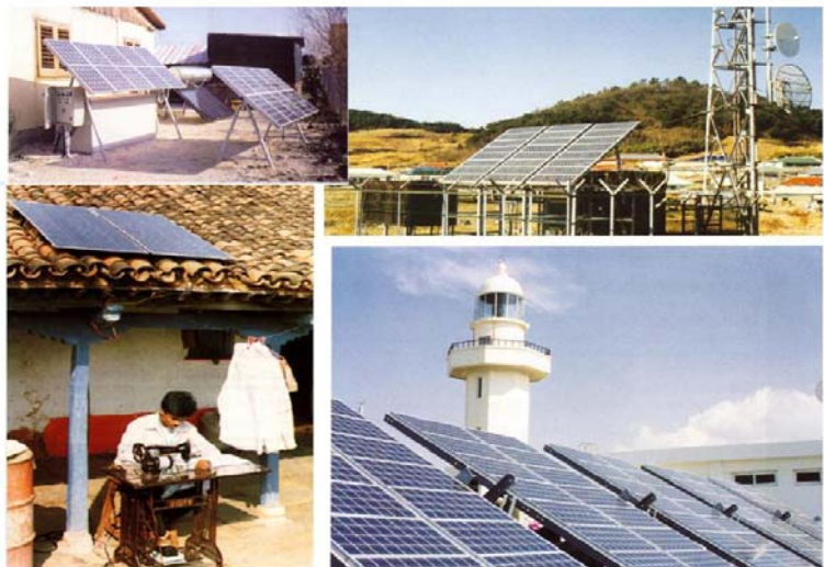
IMPIANTI ISOLATI - LE APPLICAZIONI
