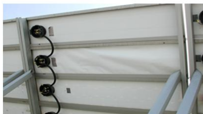
Evidente distacco del tedlar
