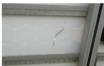
Fessurazione del tedlar
